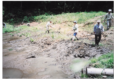
201. ボランティアによるヘドロ除去作業
